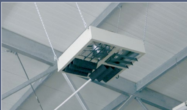
установка подпотолочного вентилятора
