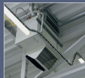
монтаж агрегата под потолок
