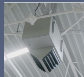
монтаж агрегата под потолок
