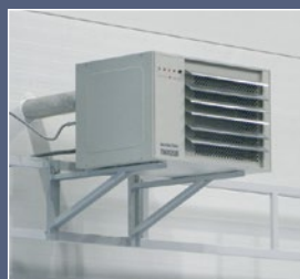
монтаж агрегата на стену
