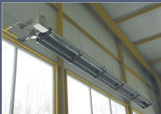
установка инфраизлучателя Helios
