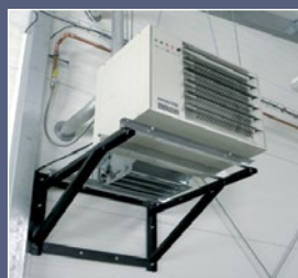
монтаж агрегата на стену
