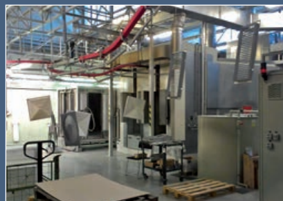
Порошковый покрасочный цех
