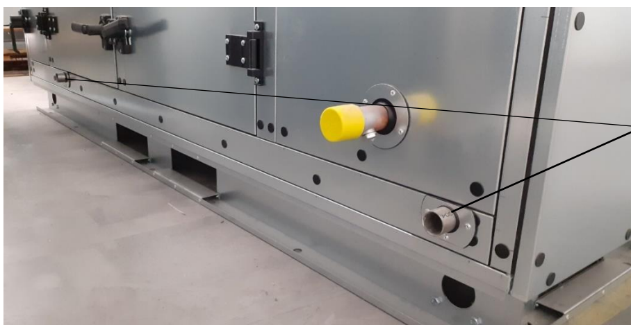
Рис. 4 Место присоединения сифона
