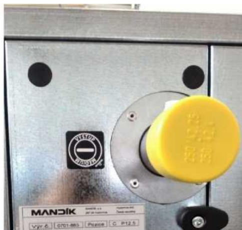
Обозначение впуска в теплообменник
