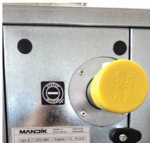
Обозначение впуска в теплообменник
