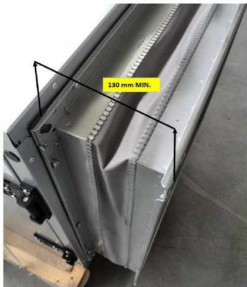
Минимальная возможная монтажная длина = 130 мм.
