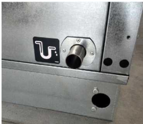
Отвод конденсата пластинчатой рекуперации (водяной/испаритель)
